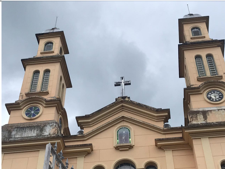
Foto 03: Alto-falantes no centro das torres da Igreja Matriz de São Sebastião – patrimônio Inventariado – apontados para frente. Data: 13/11/20. Foto: Luiza Marcondes. Trav. Flávia de Andrade Franklin / Centro / São Geraldo / MG.
