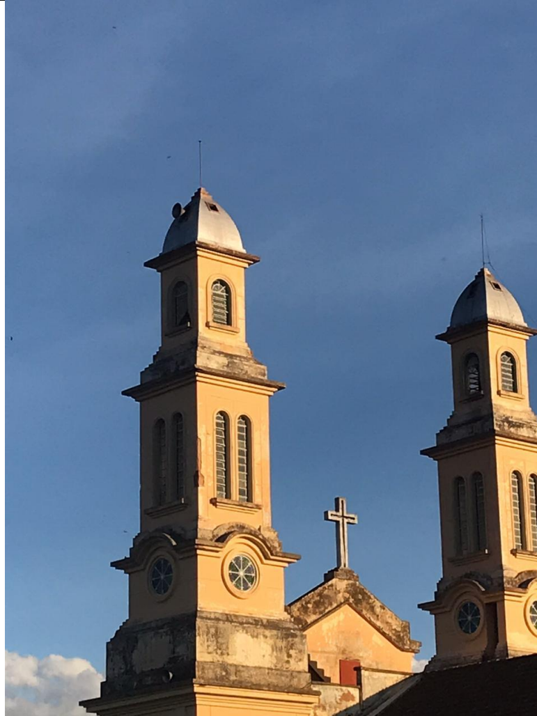
Foto 01: Alto-falantes no topo e na base de uma das torres da Igreja Matriz de São Sebastião – patrimônio Inventariado – apontados para a lateral. Data: 30/10/20. Foto: Luiza Marcondes. Trav. Flávia de Andrade Franklin / Centro / São Geraldo / MG.
